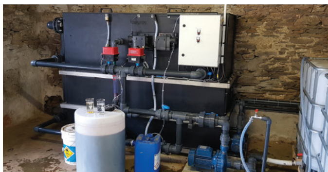
Photo 1 : Microstation calibrée et réglée sur-mesure, constituée d'un monobloc en polyéthylène non corrodable
