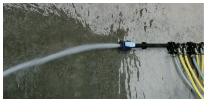
Photos 3 et 4 : Décapage mécanique avec FLUSH PIPES (crédit : Synthèse Elevage)
