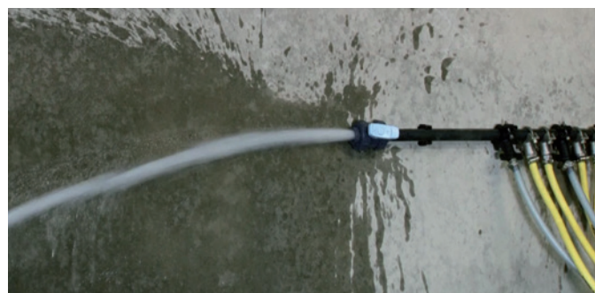
Photos 3 et 4 : Décapage mécanique avec FLUSH PIPES (crédit : Synthèse Elevage)
