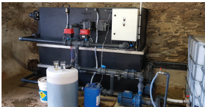
Photo 1 : Microstation calibrée et réglée sur-mesure, constituée d'un monobloc en polyéthylène non corrodable
