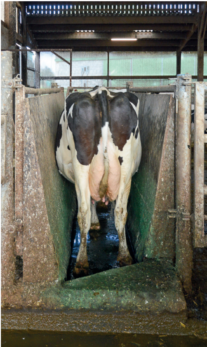
À l'entrée du pédiluve, une marche en biais incite les vaches à y pénétrer par une foulée franche. Ensuite, les parois pleines facilitent le passage des vaches. (© Cécile Julien pour Web-agri)
