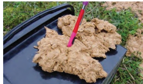
Champignons obstruant des canalisations souterraines Source : GDS 53
